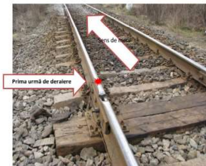
Foto 5 - prima urmă de deraiere - punctul 0 (fotografie făcută după consolidarea provizorie a liniei)
