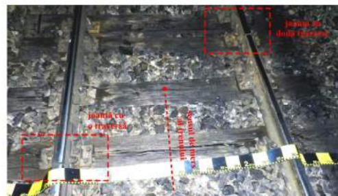
modul de alcătuire al celor două joante aflate de o parte și de cealaltă parte a punctului deraierei
