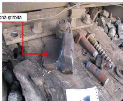
Foto 7 - cuponaș de șină care prezenta o zonă știrbită cu aspect de ruptură nouă
