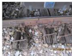
foto nr.2: Trasee necorespunzătoare de pe zona deraiată
